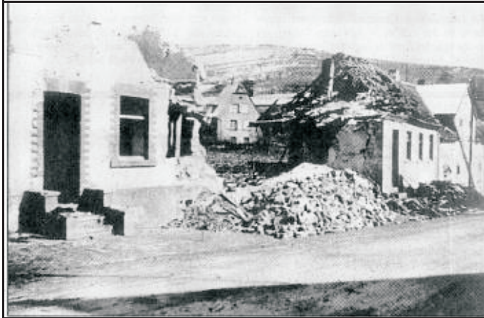
Die am 25.02.1944 zerstörten Anwesen Kiefer, Sprunck und Weber in der Neunkircher Str. in Lautzkirchen.
